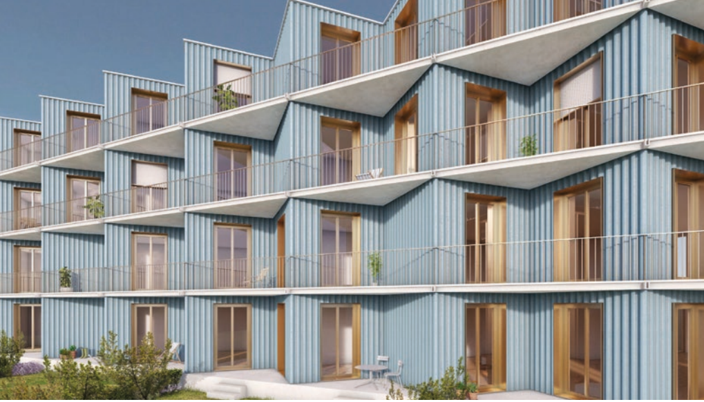
Das Fischgratmuster ermöglicht eine zweiseitige Belichtung der Räume und schafft somit Eckzimmerqualität.
